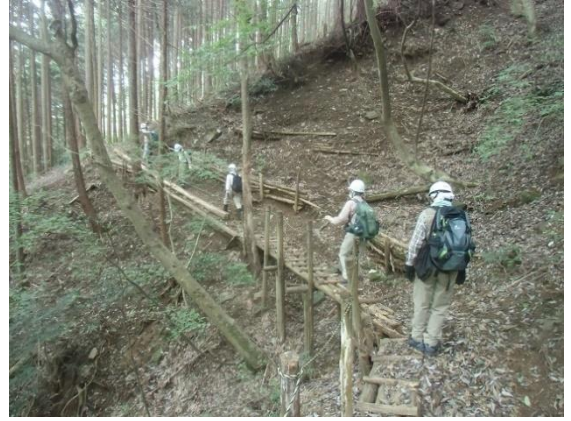
作業道：間伐材を利用した木道
