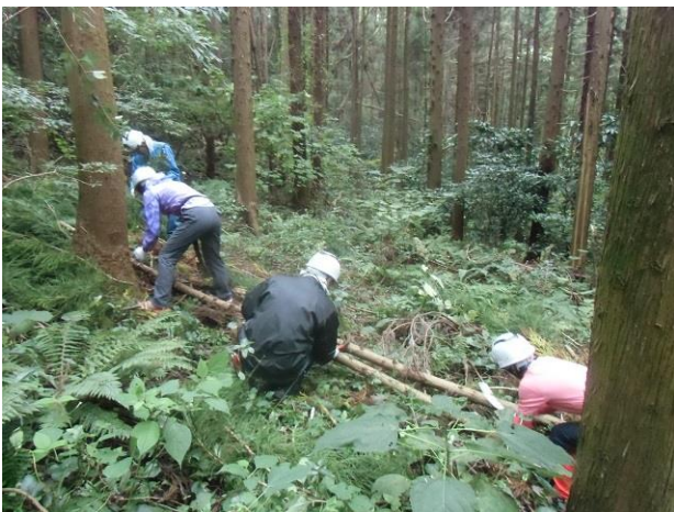
間伐の実習4：伐倒後の枝払い
