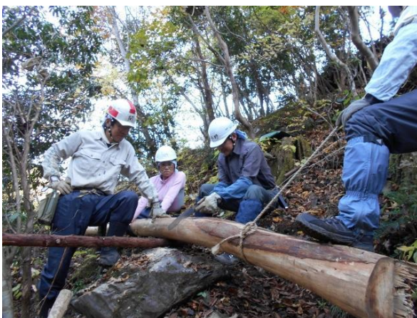
大鋸を使って材の寸法合わせ
